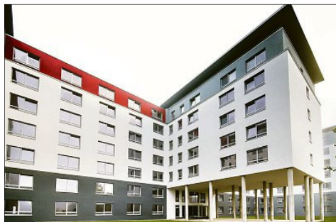
Die Rückansicht des HTCN-Erweiterungsbaus.
